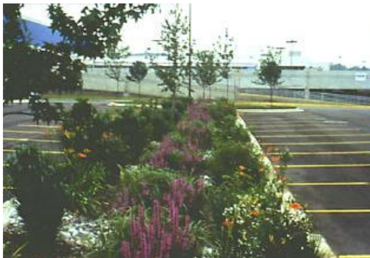
Figura 133. Exemplo de uma célula de bio-retenção colocada em um estacionamento: Dimensões: 11,6 m x 3,6 m, profundidade = 1,2 m. Um dreno subterrâneo no fundo para drenar e evitar saturação, o qual foi coberto por 20 cm de pedregulho (2,5 a 5 cm), preenchido com mistura do solo a uma profundidade de 30 cm abaixo do meio fio
